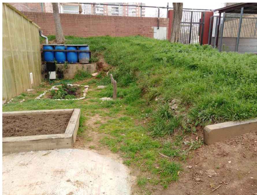
Zona mur de contenció de terres
